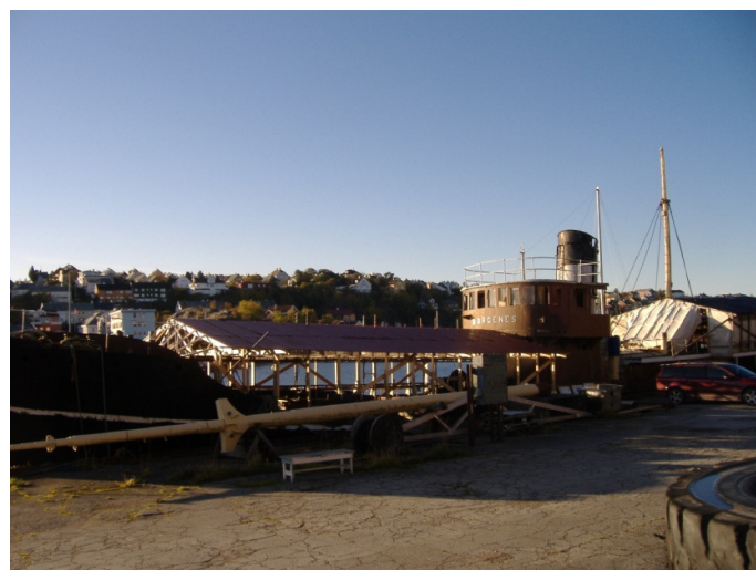
Foto: Svein Thorsø "Borgenes med tak over arbeidsdekket"
