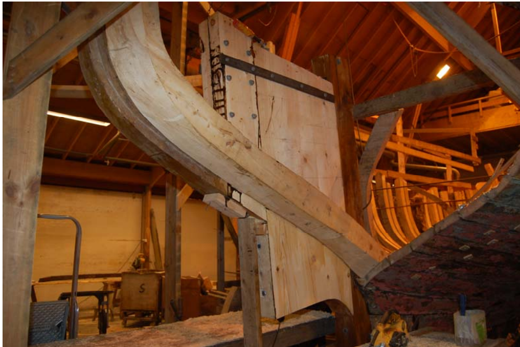
Hekkestømmeret, slangene og akterstevnen er kommet på plass.
